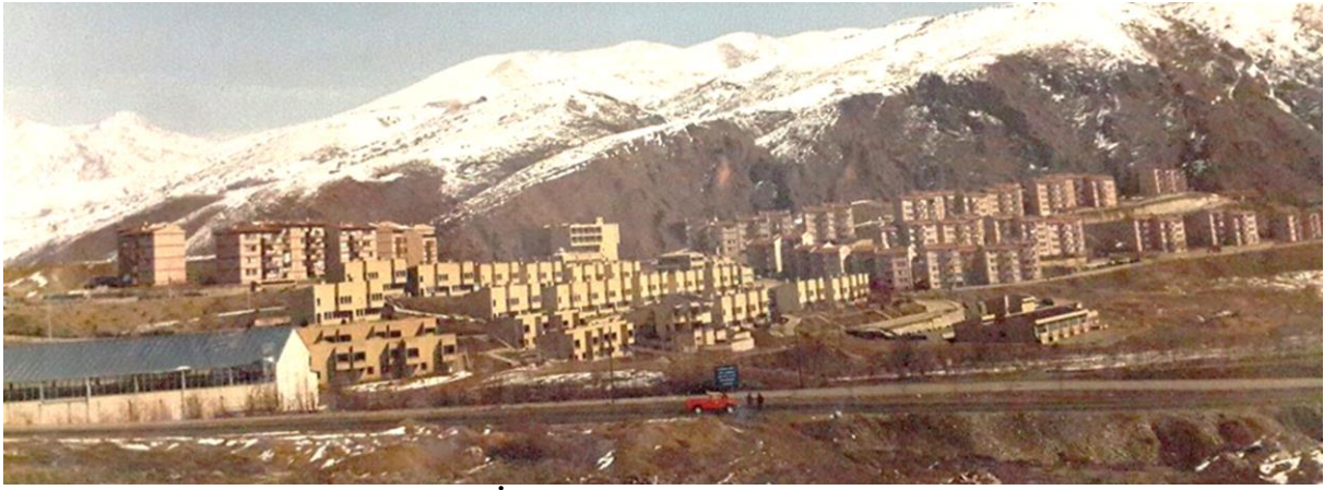
Görsel 6. Selavattepe İşçi-Memur Konutları Yerleşimi (yazar arşivi)
