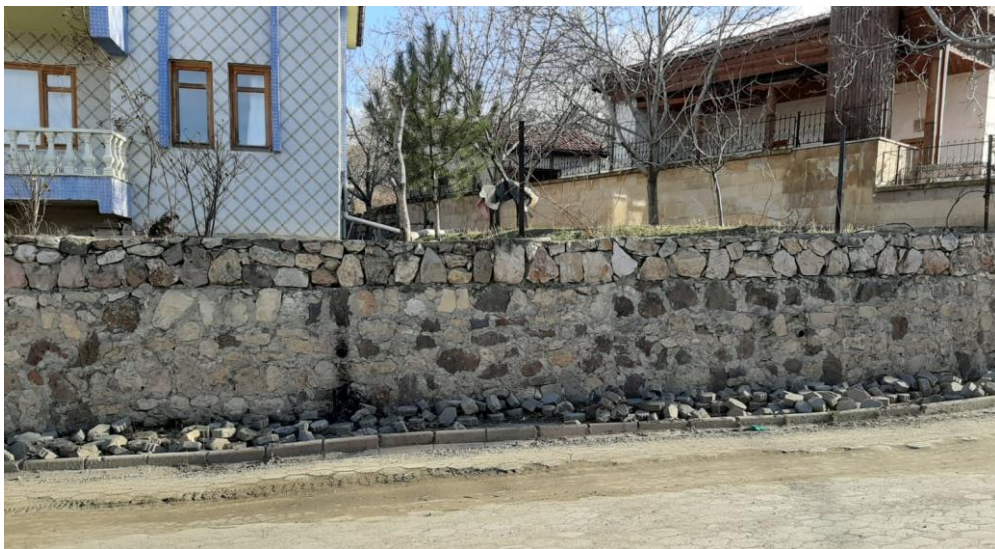
Görsel 5. Yol Genişletme Sonrası Çeşme Yeri ve Bahçe Duvarı (Yeğın, 2019)
