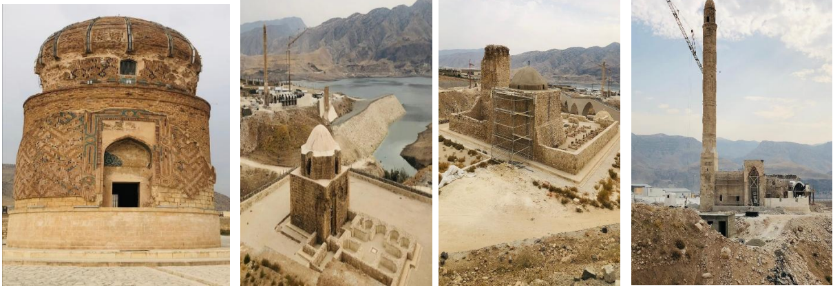
Görsel 4. İhsu Barajı Nedeniyle Taşınan Hasankeyf İlçesindeki Kültürel Miras Yapıları (Sırasıyla Zeynel Bey Türbesi, Artuklu Hamamı, İmam Abdullah Zaviyesi, Er Rızk Cami)
